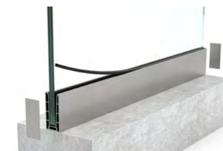
5. Paigalda tihend ja otsaplaadid.
