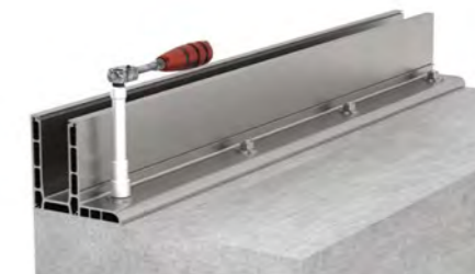
2. Paigalda profiil ja kinnita.
